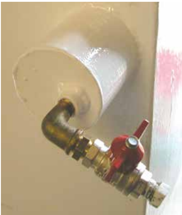
Osadnik z kurkiem spustowym i korkiem zaślepiającym
