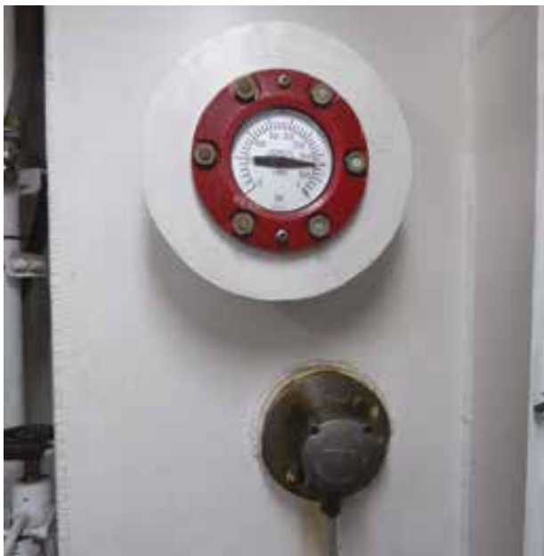
Mechaniczny wskaźnik poziomu; poniżej widać czujnik alarmu niskiego poziomu
