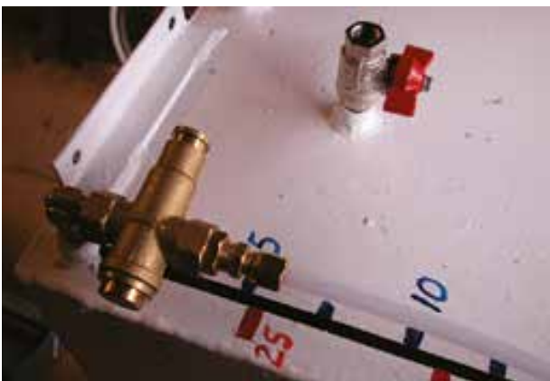
Wziernik ze sprężynowym zaworem odcinającym
