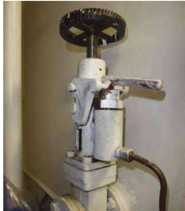
Zawór szybkozamykający: dźwignia po prawej stronie jest podnoszona przez tłoczek hydrauliczny; sprężyna zaworu jest ściśnięta, więc po przesunięciu dźwigni zatrzaśnie zawór
