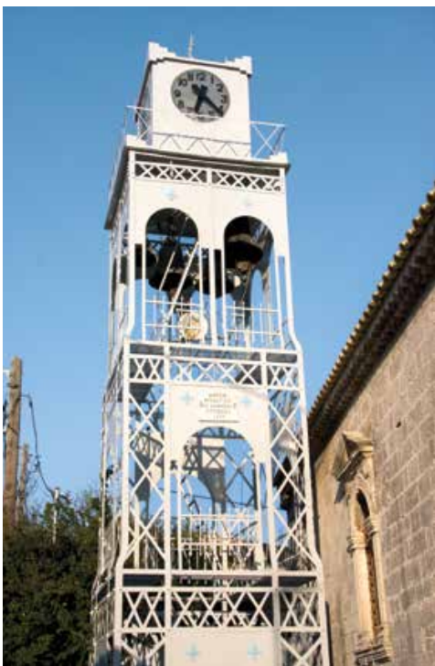
Konsekwencja trzęsień ziemi dla budownictwa: metalowa wieża zegarowa w centrum miasta – tania w budowie i odporna na wstrząsy
